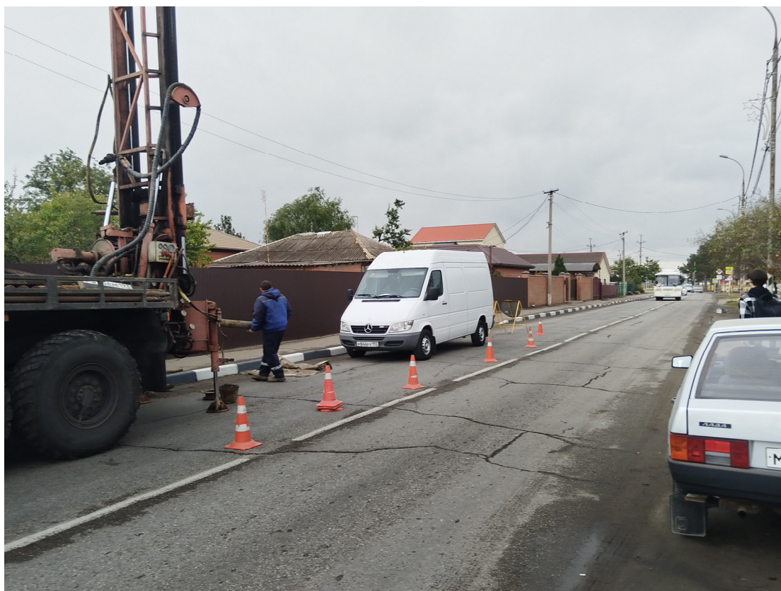
Фото 18 – Бурение скважин для разработки документации по капитальному ремонту дороге ст. Кушевская
