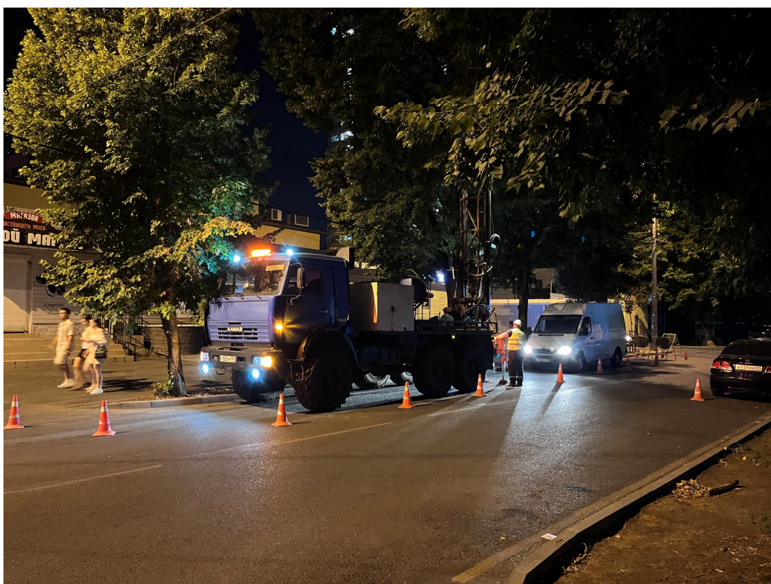
Фото 12 – Проведение буровых работ на дороге в г. Краснодар
