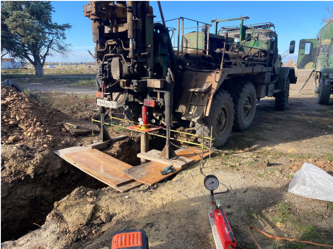
Фото 19 –Проведение штамповых испытаний на крупнообломочных грунтах для многоквартирной застройки г. Майкоп
