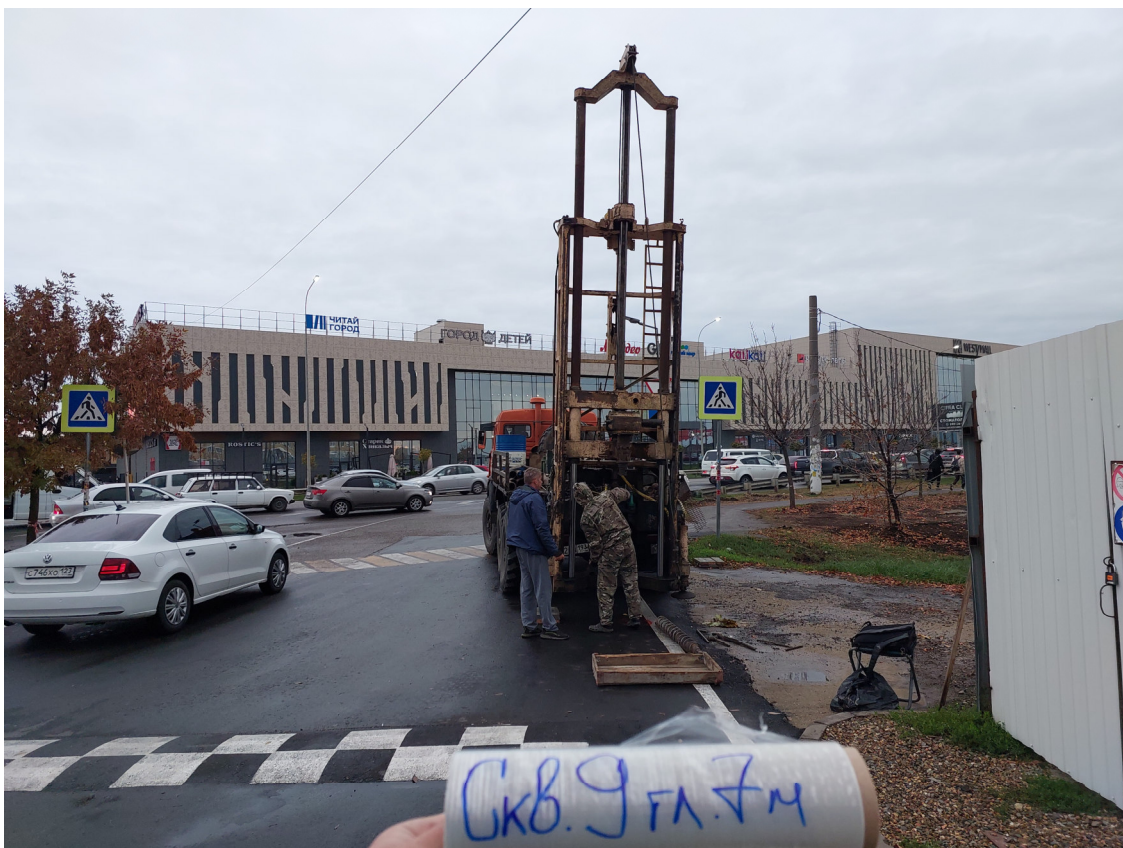
Фото 17 – Бурение скважин для разработки документации по строительству трамвайных путей г. Краснодар
