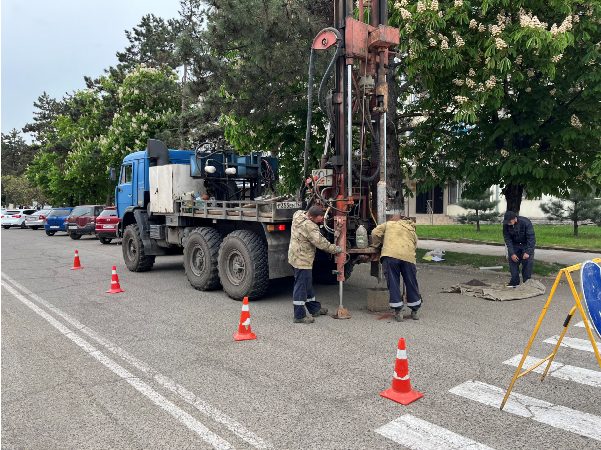
Фото 7 – Проведение буровых работ на дороге
