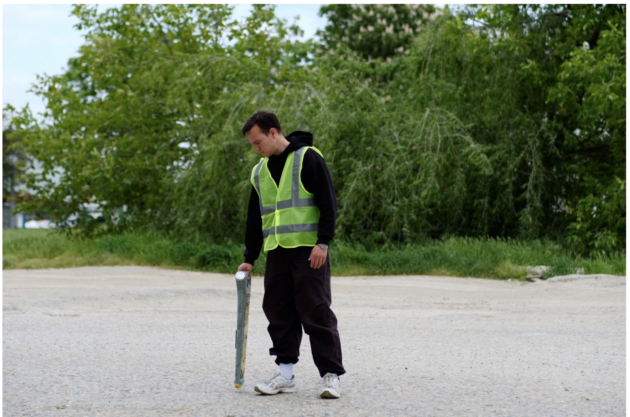
Фото 20 –Поиск подземных коммуникаций по ул. Тихорецкой на территории МЖК
