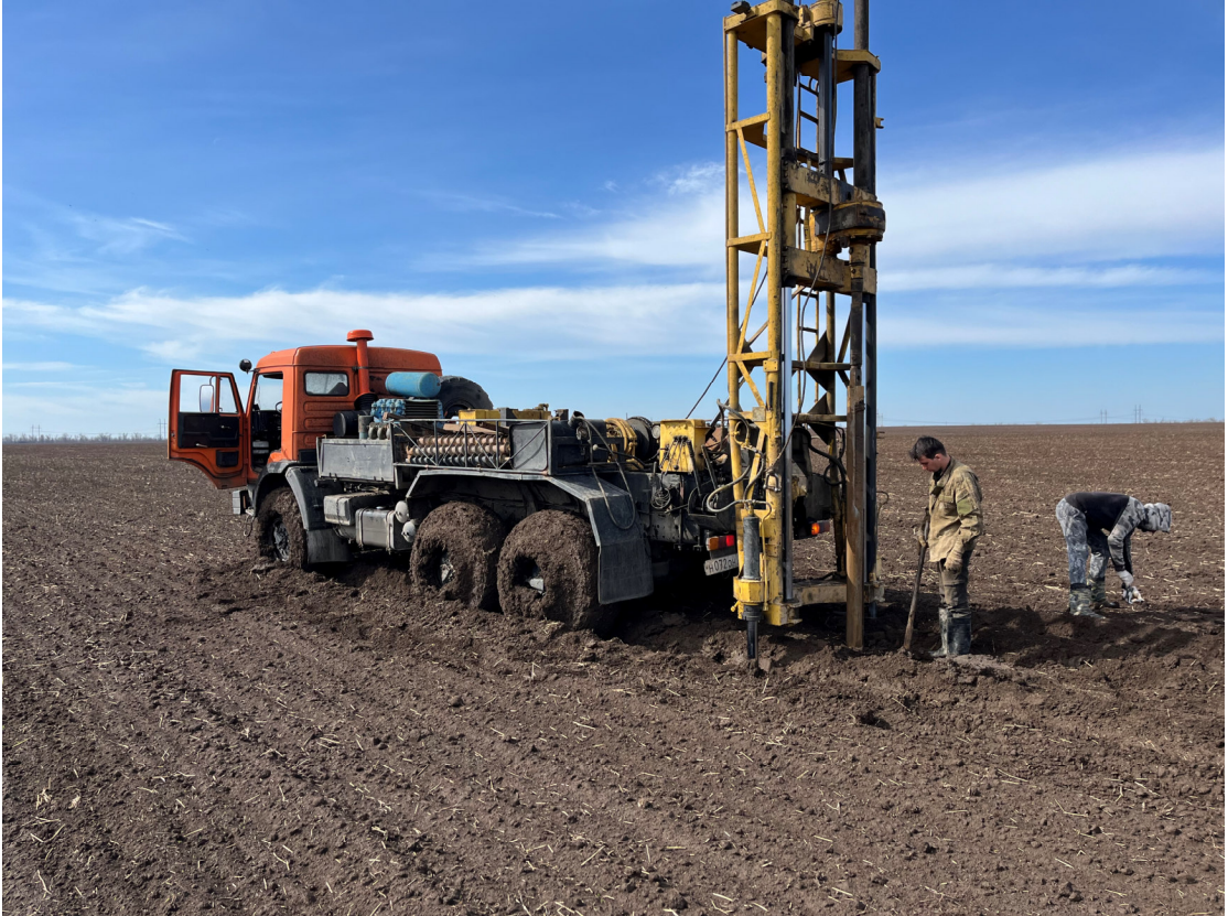
Фото 1 – Проведение буровых работ под ГРС Газпром, г. Волгодонск
