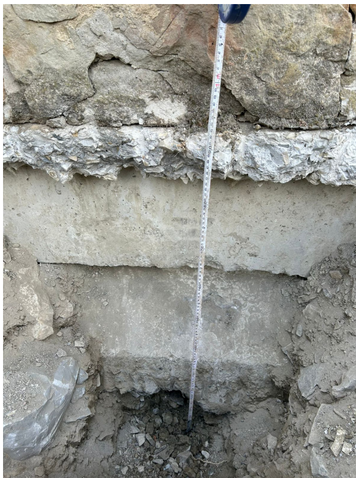
Фото 11 – Замер глубины заложения фундамента в шурфе
