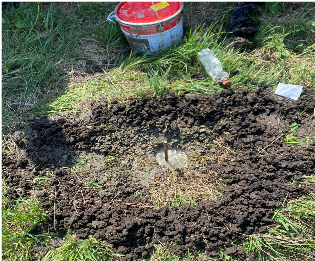
Фото 10 – Закладка пункта ГРО
